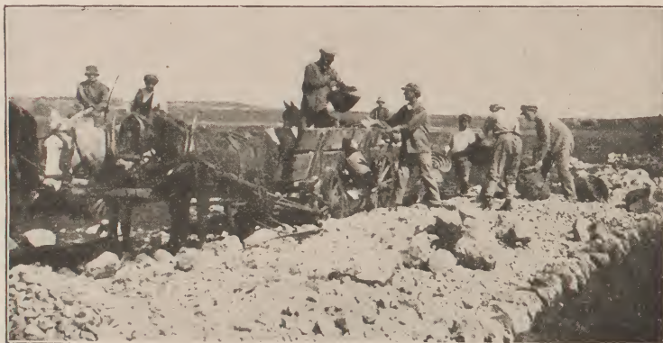
Beim Straßenbau (Palästina)
